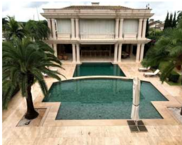
Fundos do imóvel. Em primeiro plano, o conjunto de piscinas
