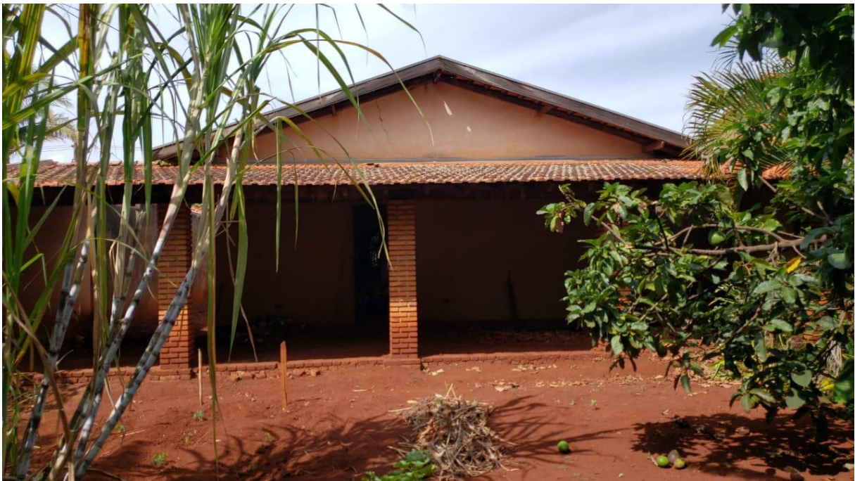
Vista parcial interna do imóvel, sob outra perspectiva dos fundos
