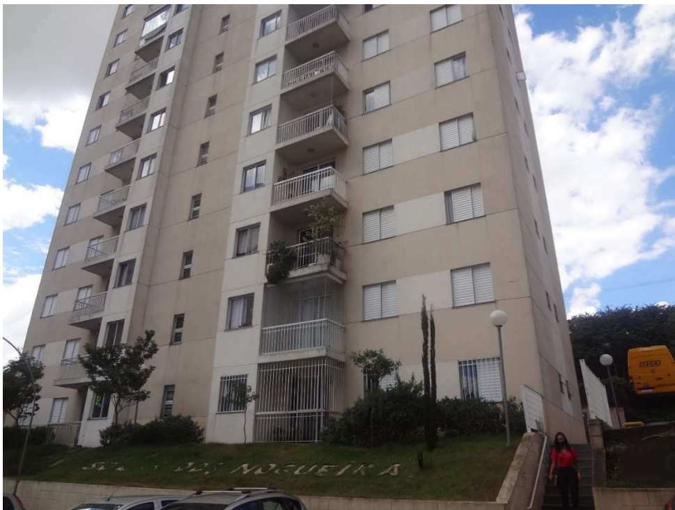
Foto 4 – Outra vista do bloco do apartamento vistoriado
