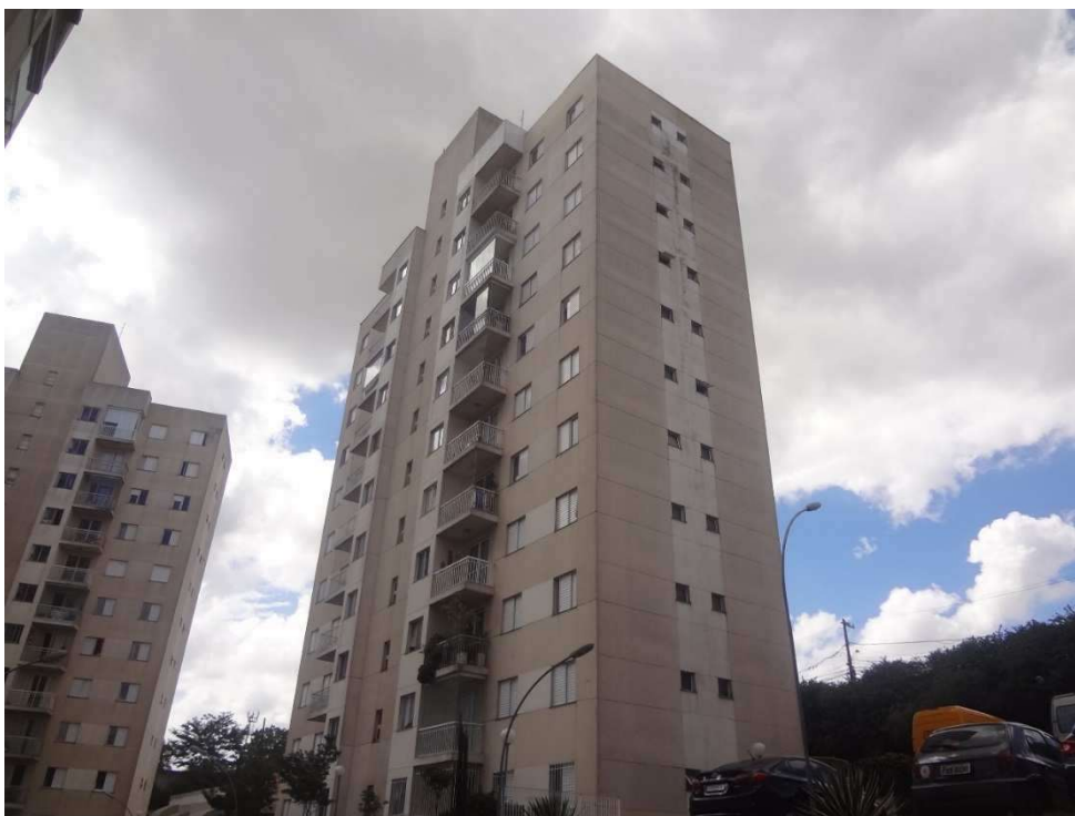
Foto 3 – Bloco do apartamento vistoriado
