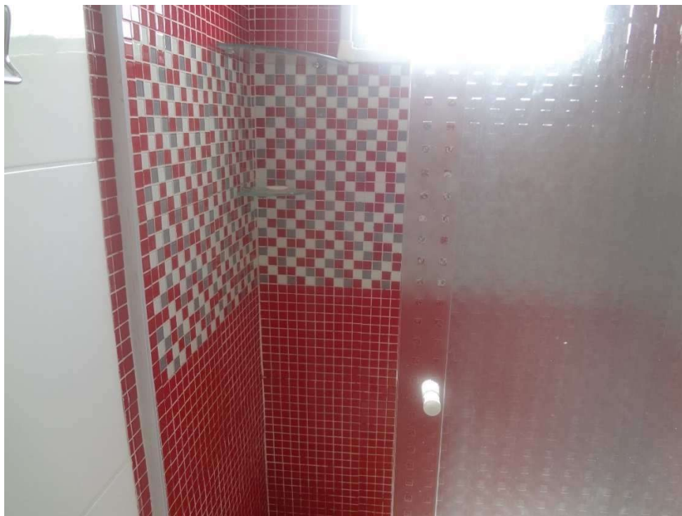
Foto 20 – Box do banheiro
