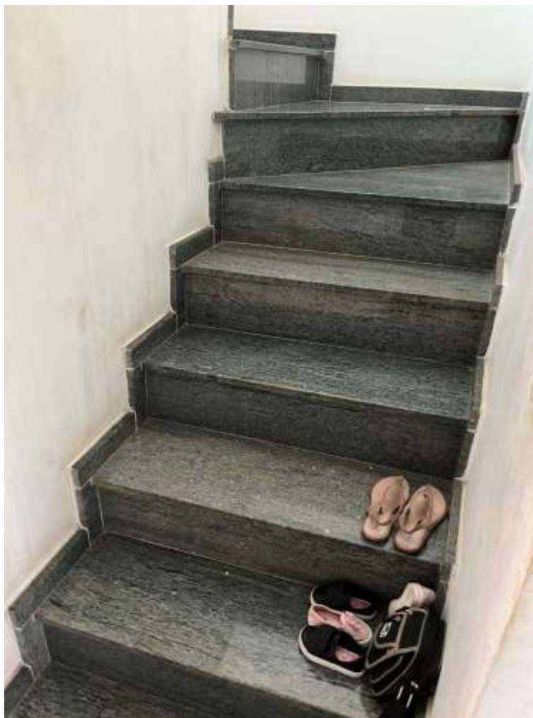
Foto nº. 12 – Vista da escada de acesso ao pavimento superior.
