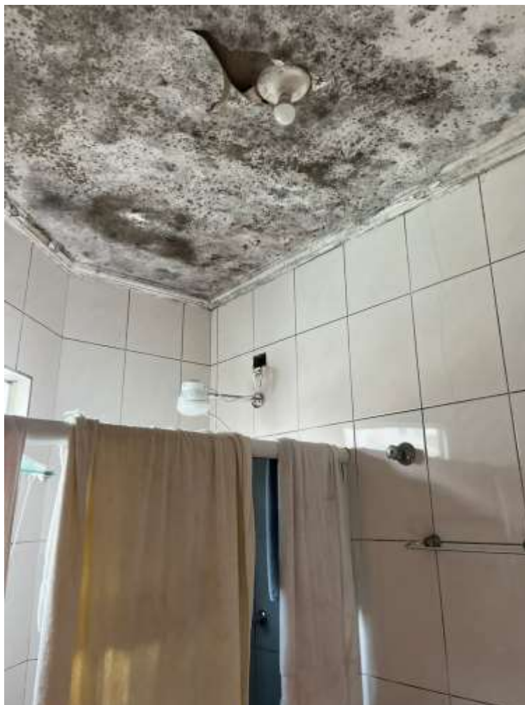
Foto nº. 17 – Outra vista do banheiro suíte.
