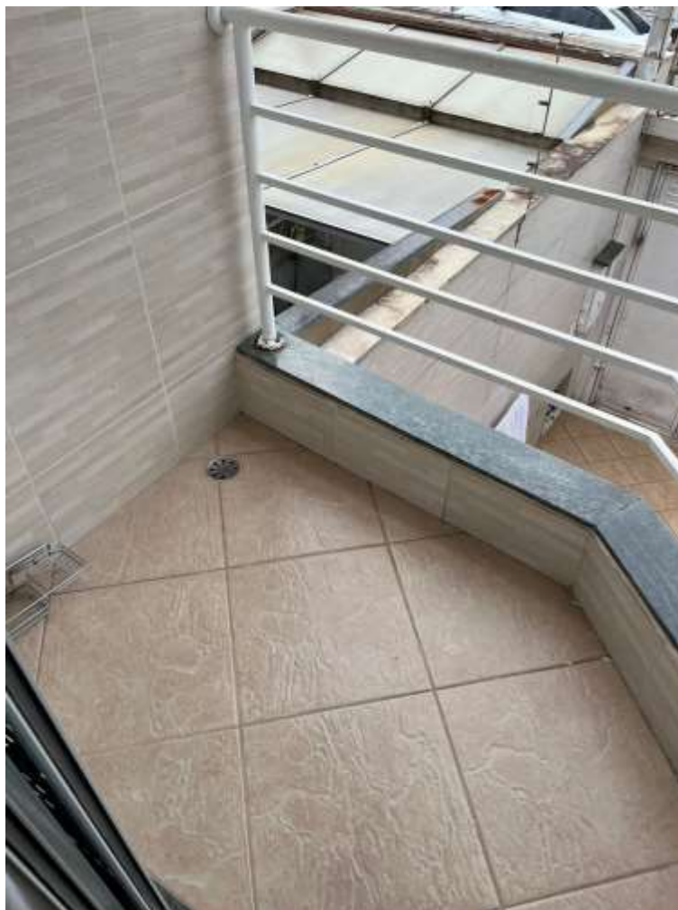
Foto nº. 18 – Vista da varanda.
