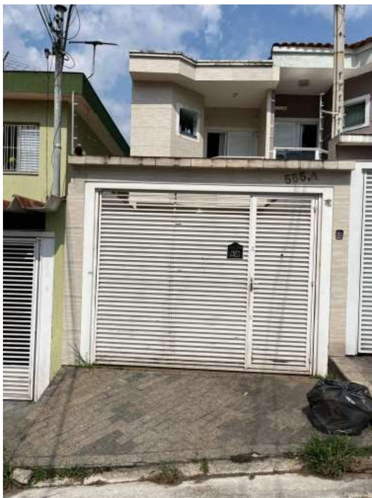
Vista da fachada do imóvel avaliando.
