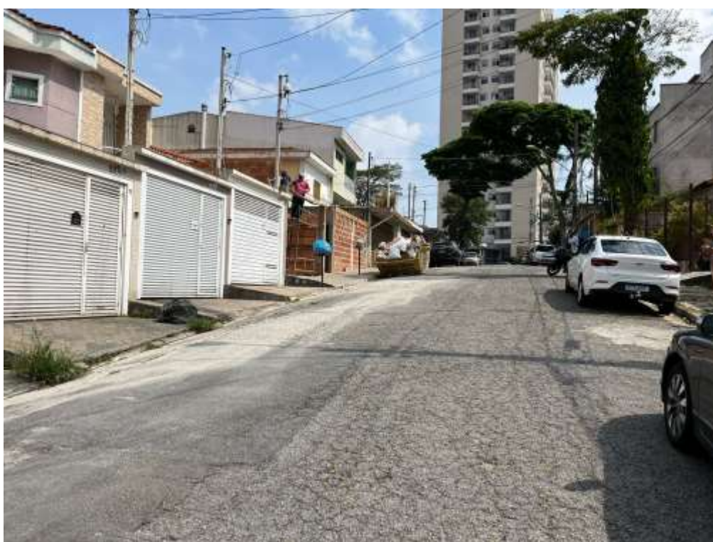
Foto nº. 1 – Vista da Rua Tupinambás, onde se localiza o imóvel avaliado no presente laudo.
