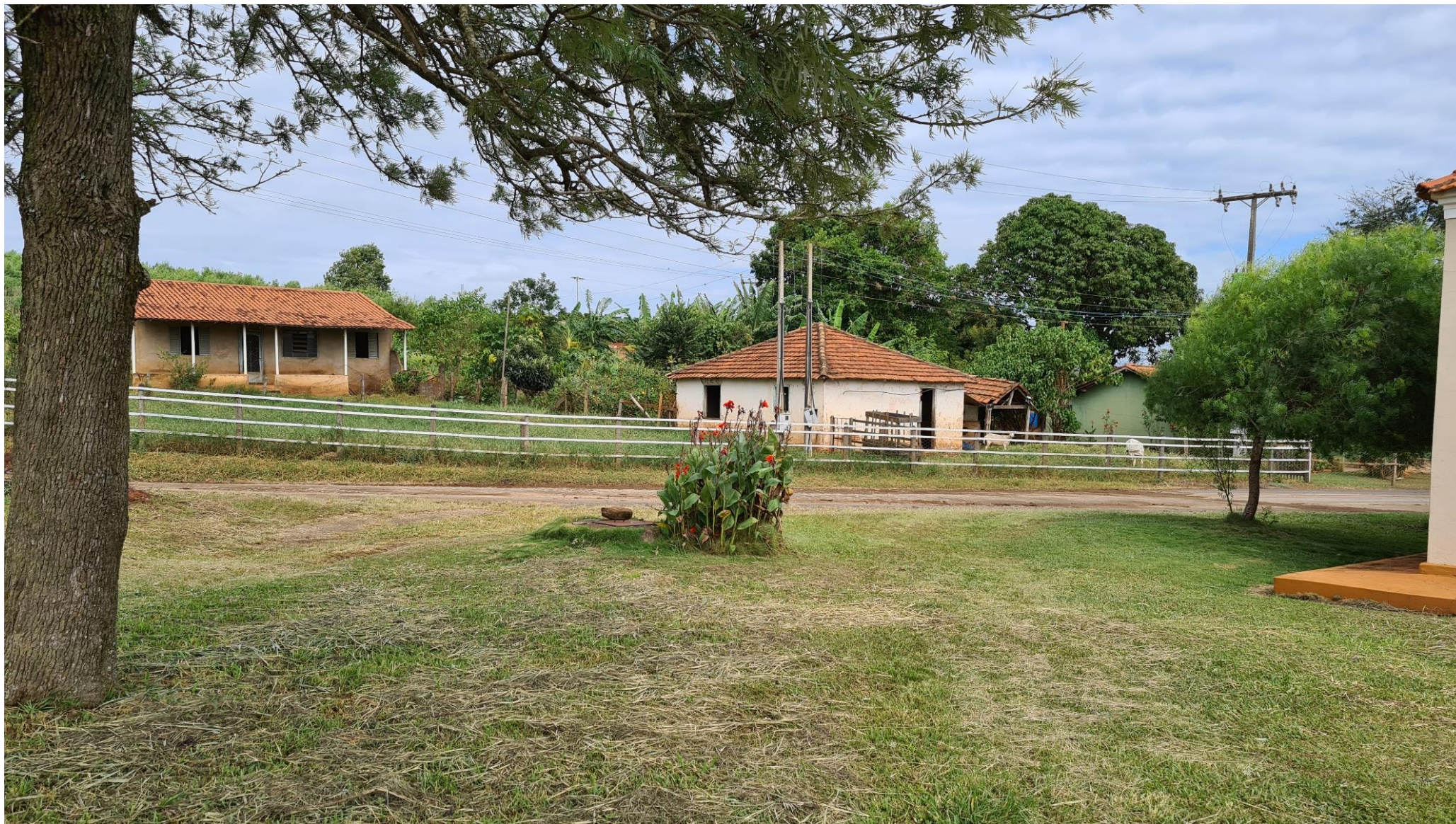
FOTO 03- Casas desocupadas (Matrícula 1.778- Fazenda Barra grande -Bairro da China-Cel Macedo-SP
