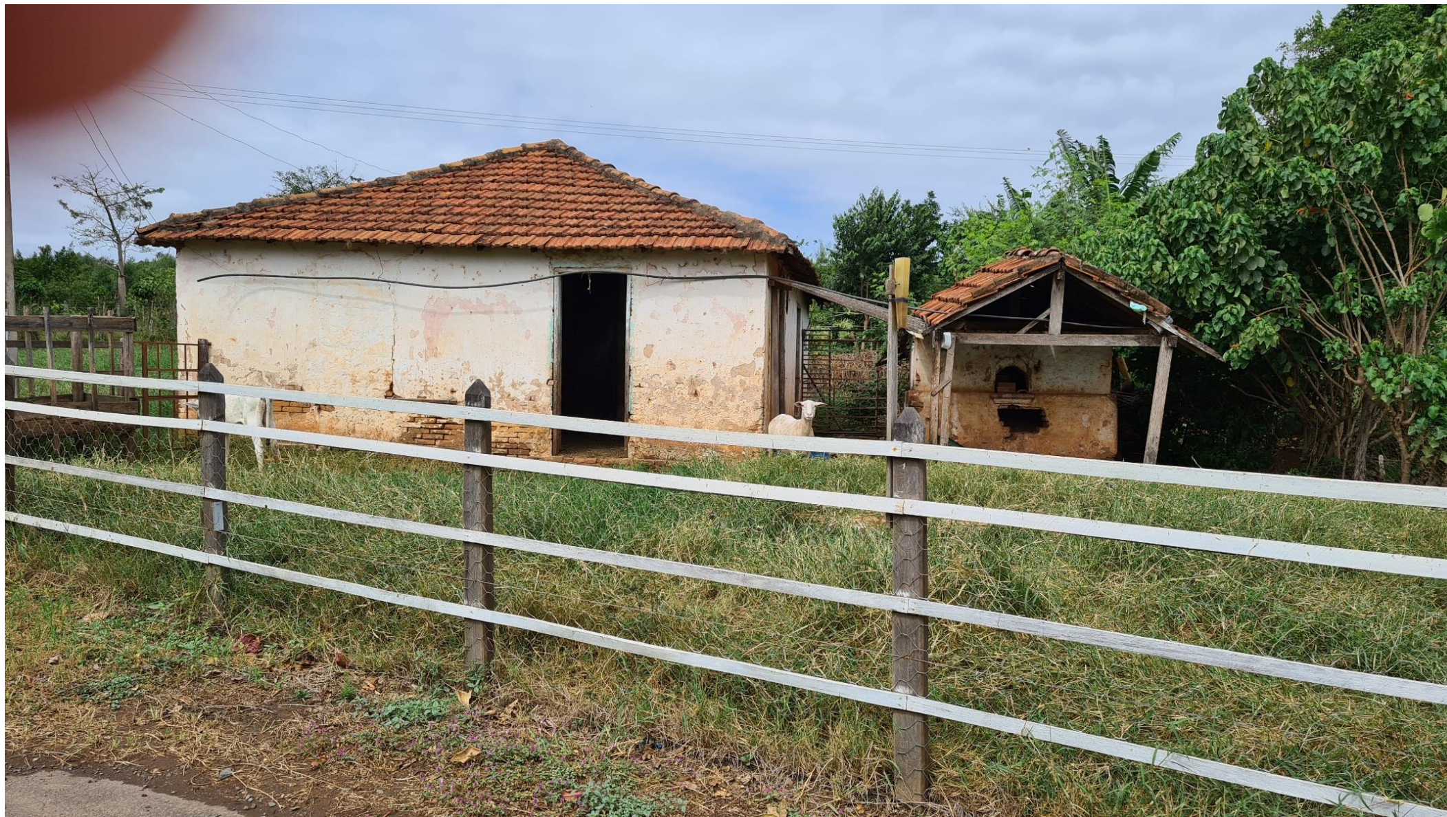
FOTO 02- Casa desocupada pertencente a Igreja(Matrícula 1.778- Fazenda Barra grande -Bairro da China-Cel Macedo-SP
