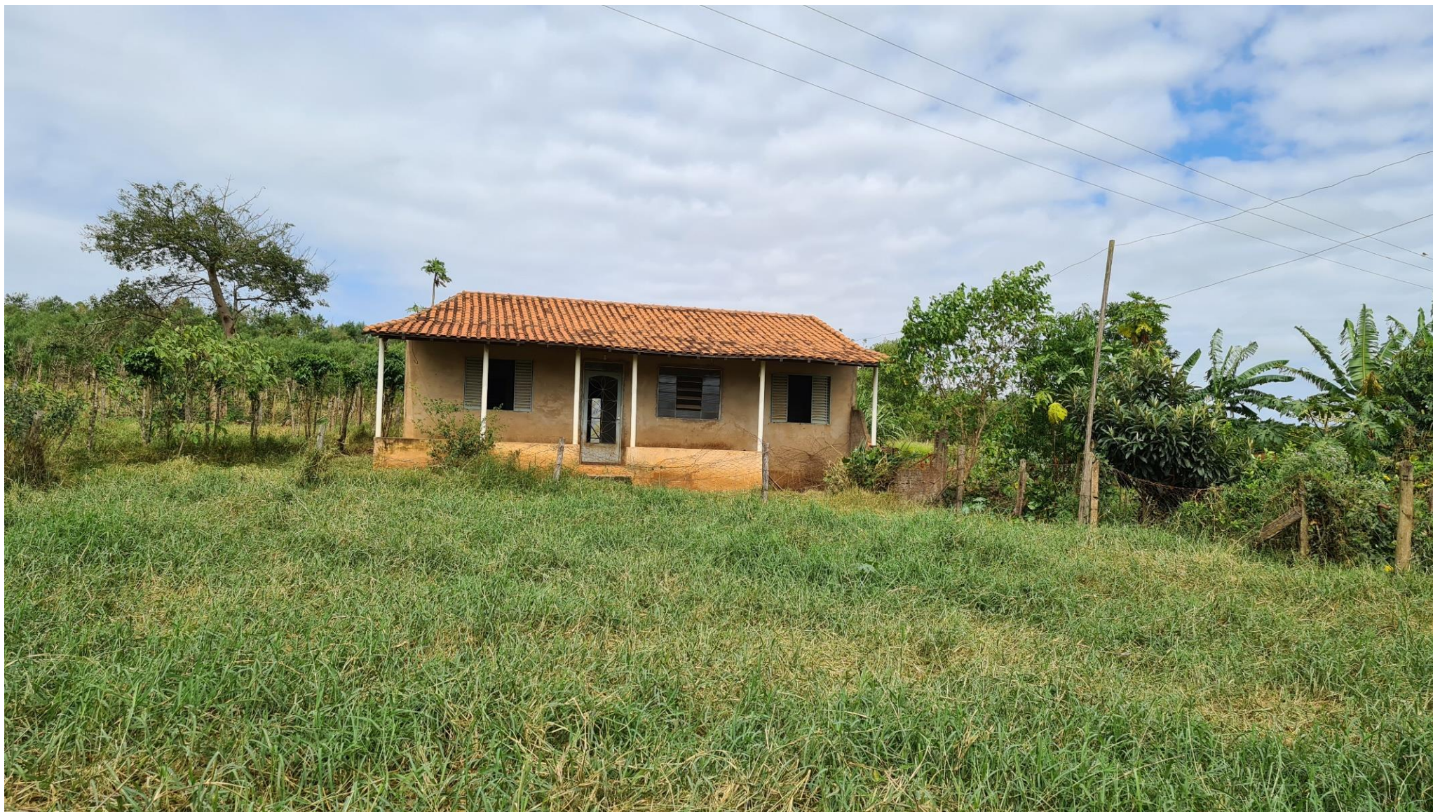
FOTO 04- Casa 01 desocupada, do Sr. Valdeci Pereira Sobrinho (Matrícula 1.778- Fazenda Barra grande -Bairro da China-Cel Macedo-SP
