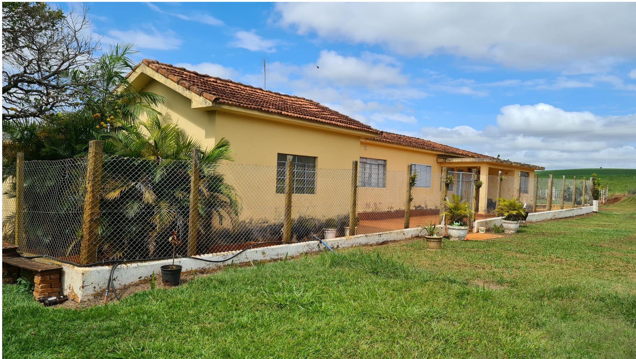
FOTO 04- Casa-Sede da fazenda(Matrícula 5.022- Fazenda “Palmeira dos Neves”-Bairro dos Neves-Taquarituba-SP.)
