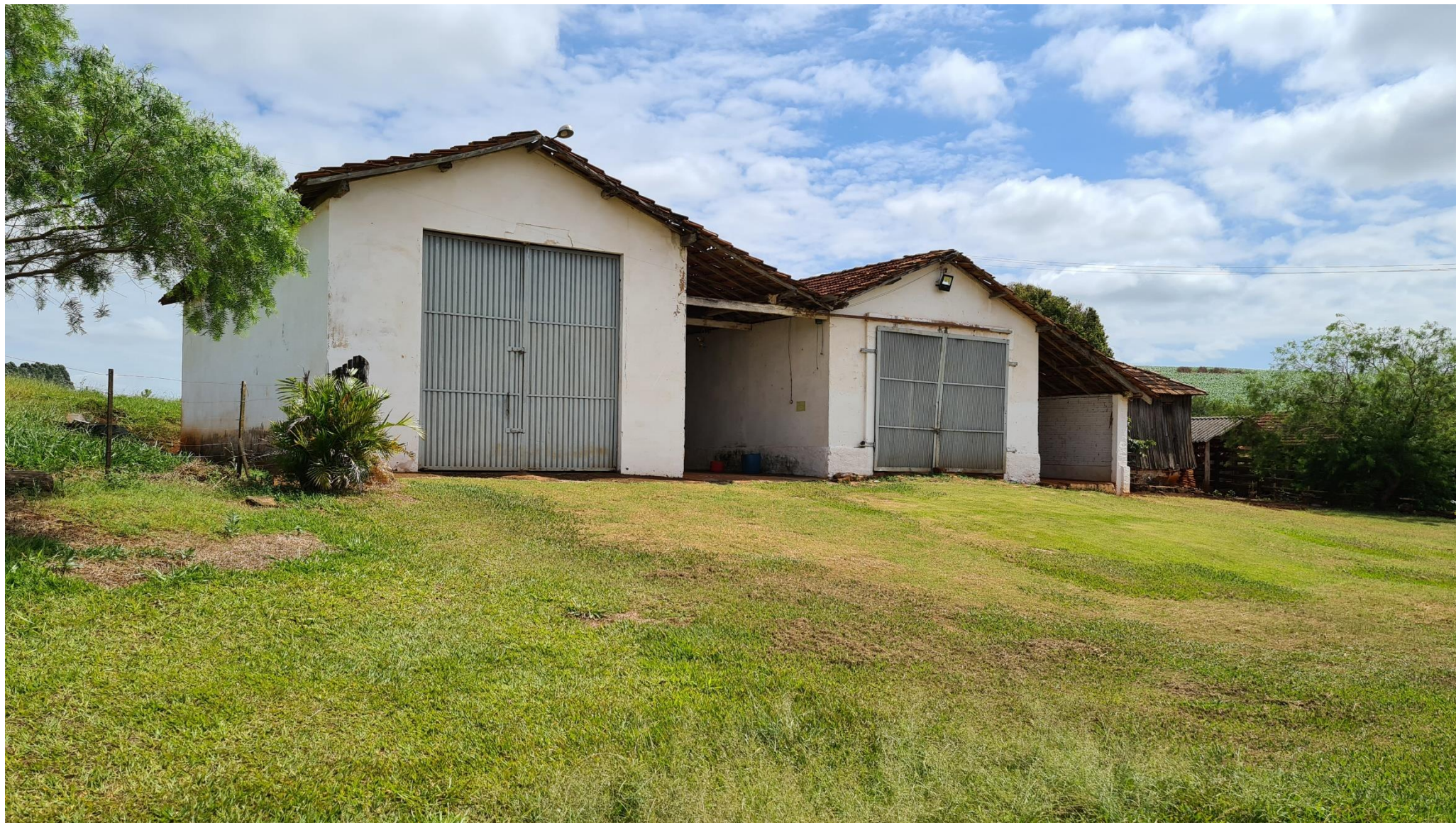
FOTO 05- Barracões na sede da fazenda (Matrícula 5.022- Fazenda “Palmeira dos Neves”-Bairro dos Neves -Taquarituba-SP.)
