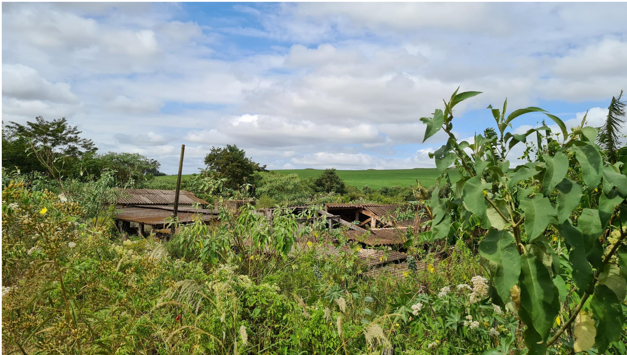
FOTO 14- Construção no mato, na divisa- foi utilizada como chiqueiro(Matr 5.022- Faz. “Palmeira dos Neves”-Bairro dos Neves-Taquarituba-SP)
