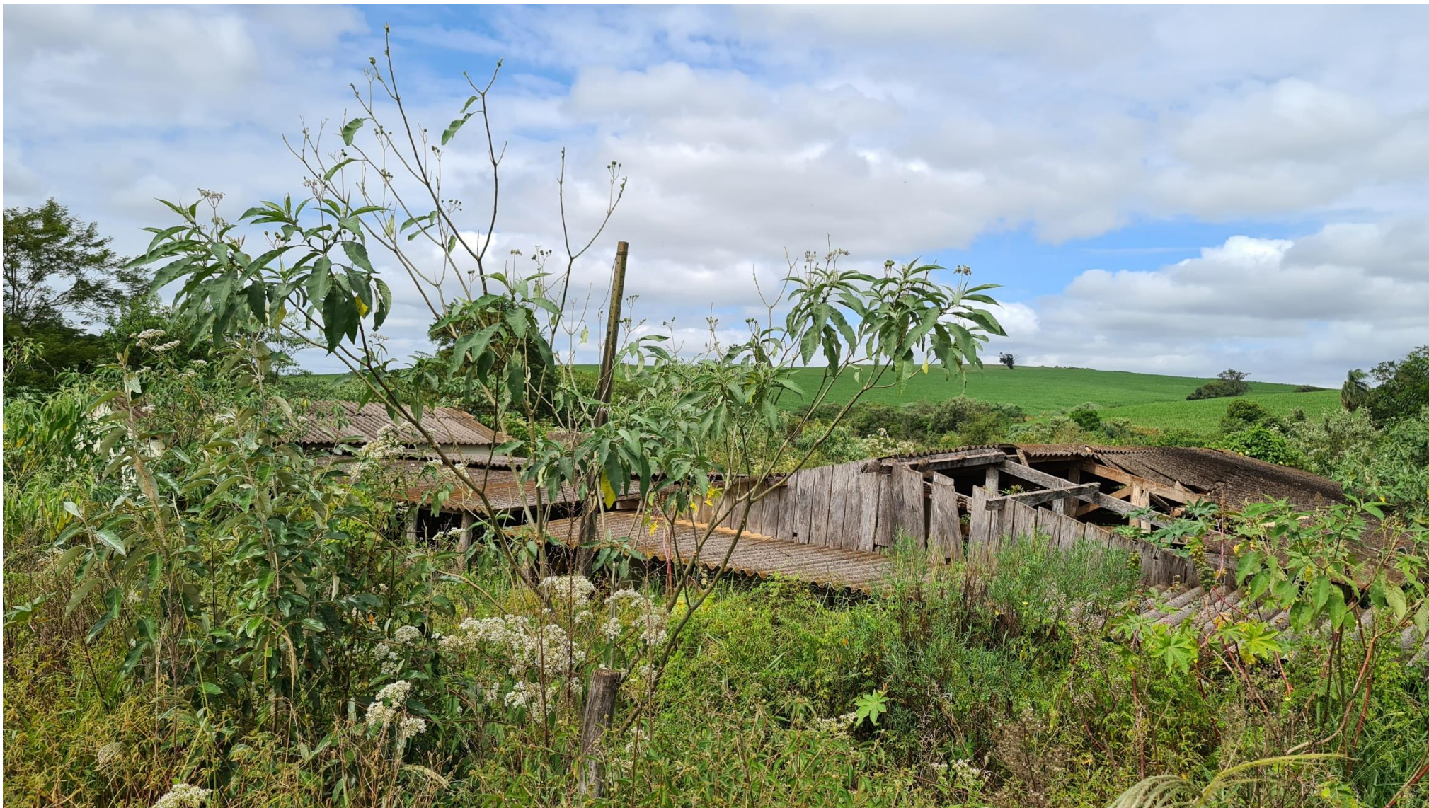
FOTO 15- Construção no mato, na divisa- foi utilizada como chiqueiro(Matr 5.022- Faz. “Palmeira dos Neves”-Bairro dos Neves-Taquarituba-SP)
