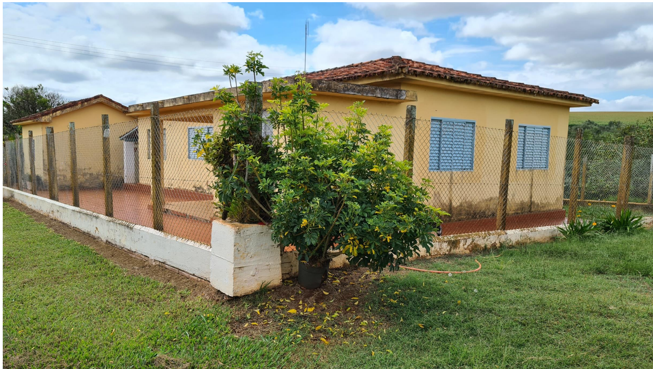
FOTO 03- Casa-Sede da fazenda (Matrícula 5.022- Fazenda “Palmeira dos Neves”-Bairro dos Neves-Taquarituba-SP.)
