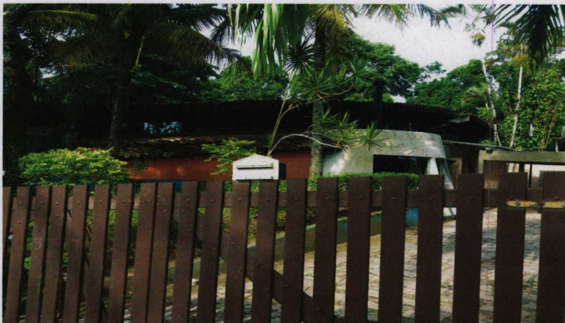
Foto 9 – Entrada do Lote 4, com visão da construção, o que parece ser uma área de lazer, pela imagem de uma chaminé, provável churrasqueira, no Lote 5.
