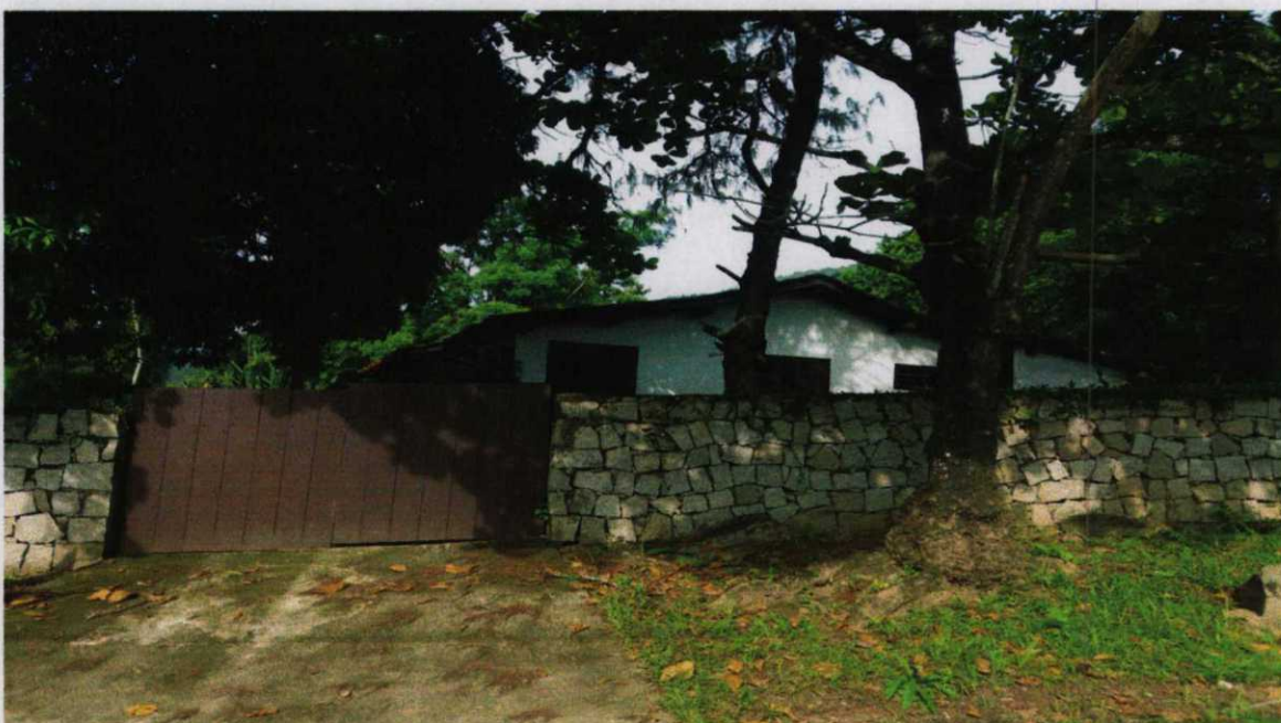
Foto 14 – Imagem da casa/construção e portão de acesso, provável Lote 3, embora tenha um terreno livre ao lado, como será visto nas próximas fotos.
